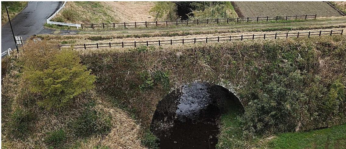
点検結果：アーチ部の石材間に開きが見受けられ、上部土砂による側圧にて上下流方向に開いたと考えられる。しかしアーチ縦断方向に大きな開きは確認できな。経過観察は必要と考えられる。
