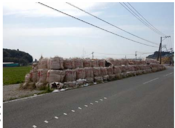
圧密沈下促進状況
