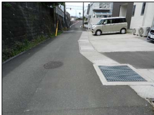
側溝設置による排水経路変更
